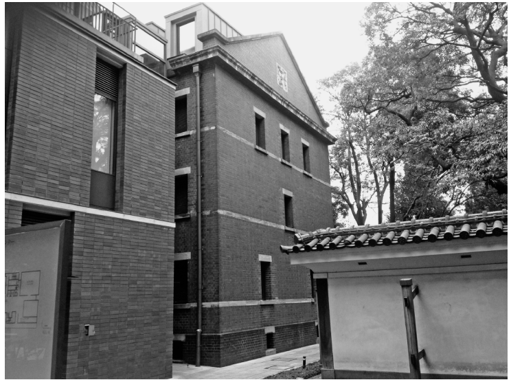
写真1 赤門書庫外観（現況、奥の建物）
