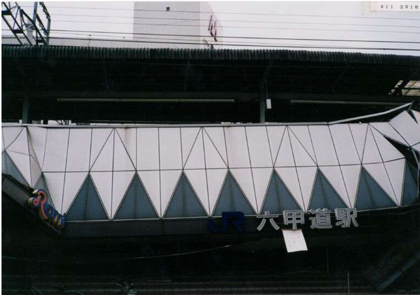
「駅舎・高架橋の倒壊したJR六甲道駅。」（谷通好撮影、神戸大学附属図書館制作、CC BY 4.0）
